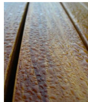
Mit Holzschutzmittel behandeltes Holz.
